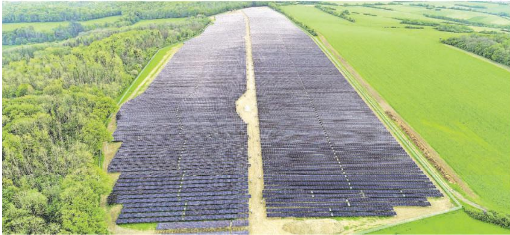
Der Bürger-Solarpark Bliesransbach ist fertig und seit März am Netz.
